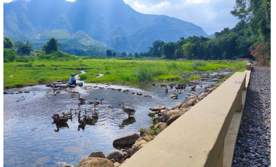
乳源新街水碧道
